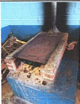
Foto 5: Sustitución de estufa rural con chimenea, plancha y accesorios.
