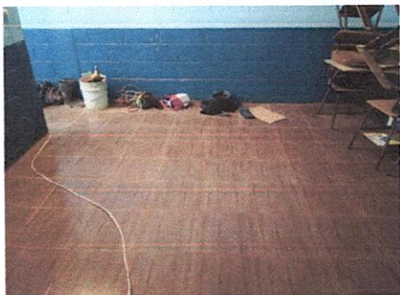
Foto 1: Sustitución de piso, por piso cerámico en áreas de aulas, dirección, bodega y corredor.
