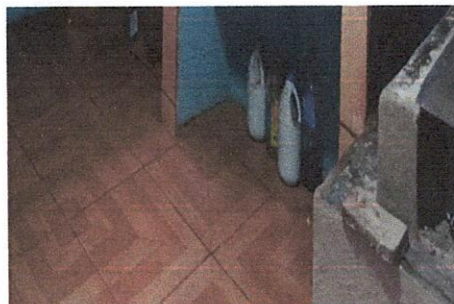
Foto 2: Sustitución de piso de acabado liso, por piso cerámico antideslizante en área de cocina.
