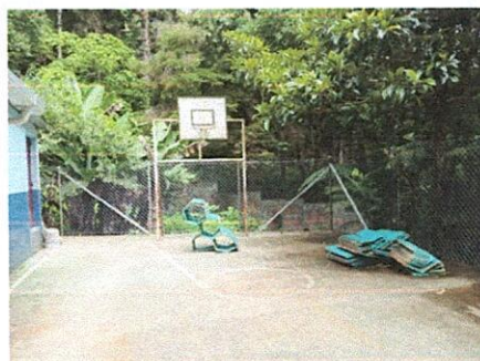
Foto 4: Sustitución malla de acero galvanizado en perímetro del establecimiento, con instalación fija y tensa, anclajes metálicos en intervalos regulares.
